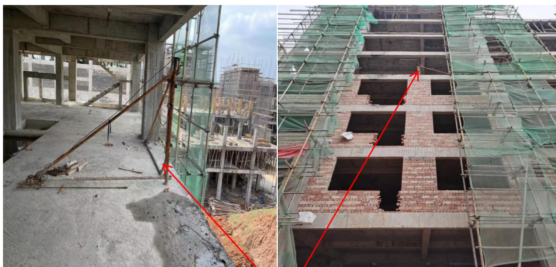
简易吊机三角基座架安装位置
