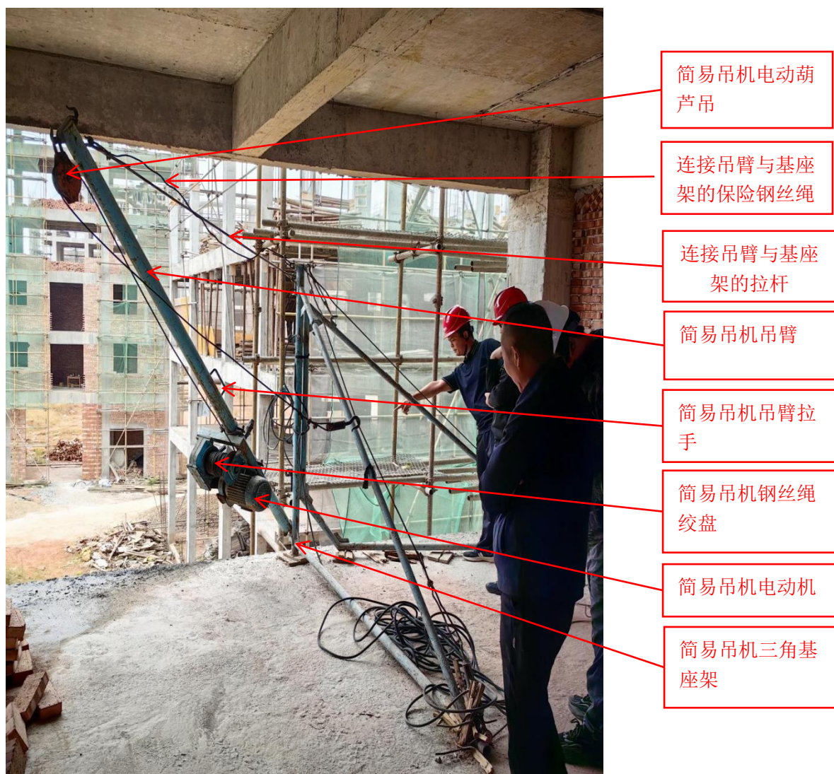
(简易吊机构造示意图)
