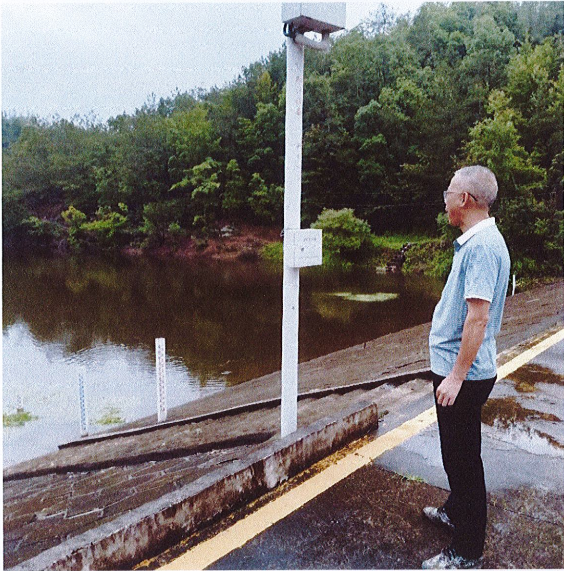
附件：排查山塘水库现场照片
